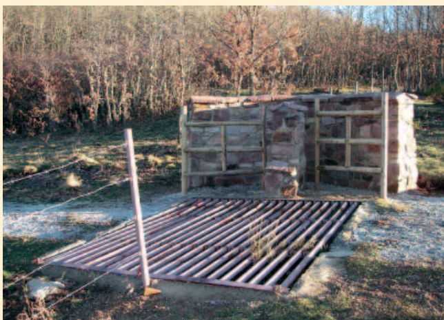
3. La pista de acceso tiene un paso canadiense para impedir el paso al ganado y paso lateral para personas.
